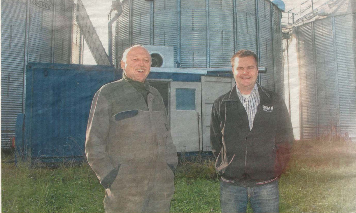
TORKAR MED BIOBRÄNSLE. Hemma hos Arne Andrae utanför Lidköping provkör den fastbränsleeldade varmluftspanna på 300 kilowatt som tillverkas av kusinbarnet David Andraes bolag Vänertekno. FOTO: GÖRAN BERGLUND
